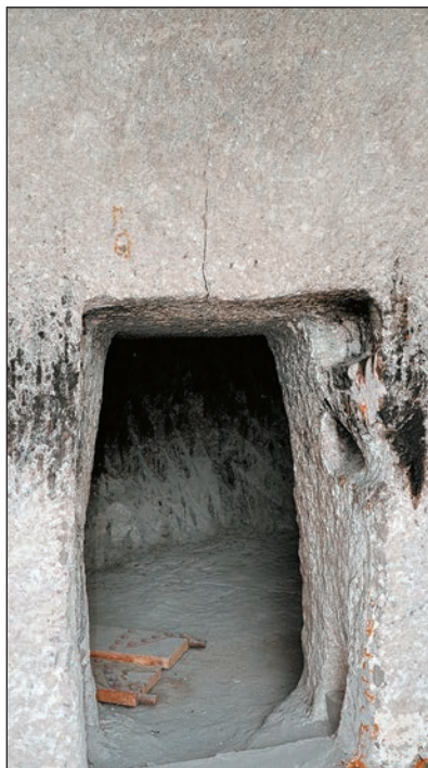
Субмеридиональные трещины над оконными и дверными проемами внутренних комнат пещерного города.
