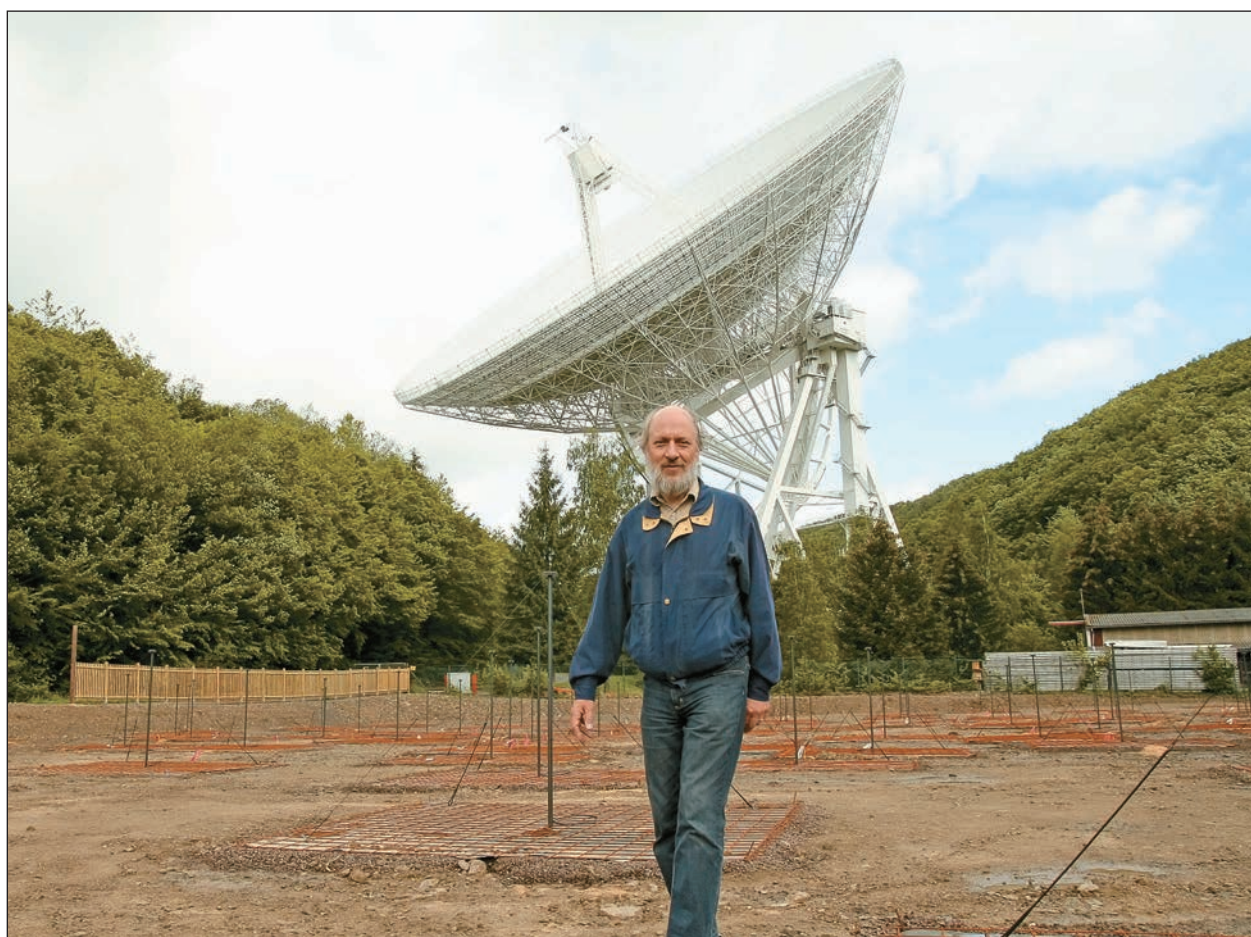
Рис.3. Вид радиотелескопа сильно зависит от его конструкции. На рисунке одновременно показана тарелка телескопа в Эффельсберге, а перед ней видны антенны находящейся там же станции телескопа LOFAR. Последний — интерферометр, он собирает сигнал со многих станций, расположенных в нескольких европейских странах, а центральное ядро телескопа находится в Голландии. На переднем плане мы видим автора снимка — одного из ведущих наблюдателей магнитных полей галактик Райнера Бека из Института радиоастрономии общества имени Макса Планка.
