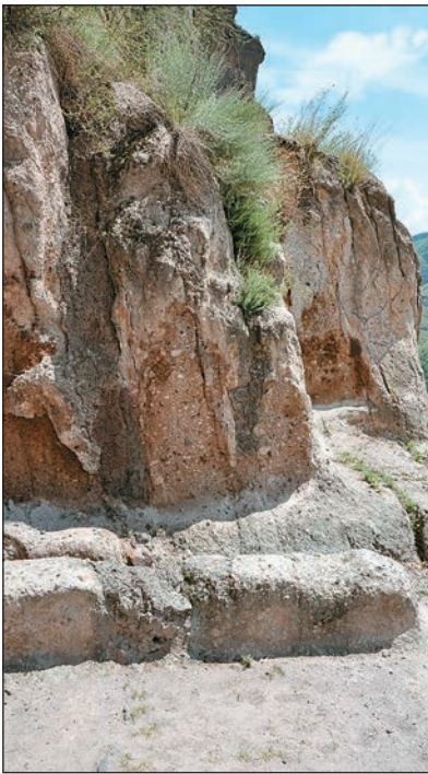
Протяженные субширотные трещины со смещением (слева) в присклоновой части Вардзи и трещины, секущие лестницы и пространство над лестничными маршами.
