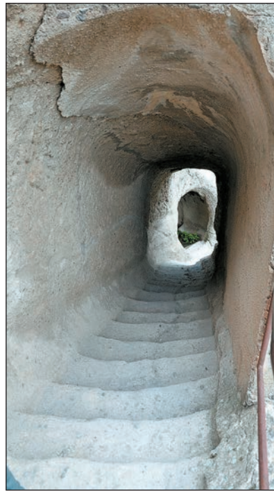
Протяженные субширотные трещины со смещением (слева) в присклоновой части Вардзи и трещины, секущие лестницы и пространство над лестничными маршами.
