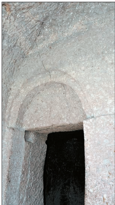
Субмеридиональные трещины над оконными и дверными проемами внутренних комнат пещерного города.
